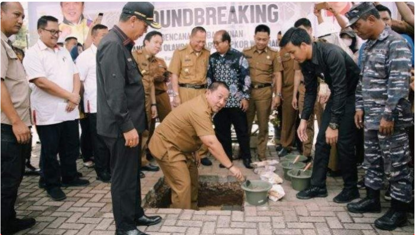
Ketua DPRD Lampung Mingrum Gumay Hadiri Groundbreaking Pembangunan GOR Saburai
